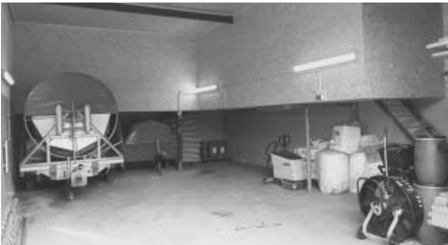
Die neue Halle
