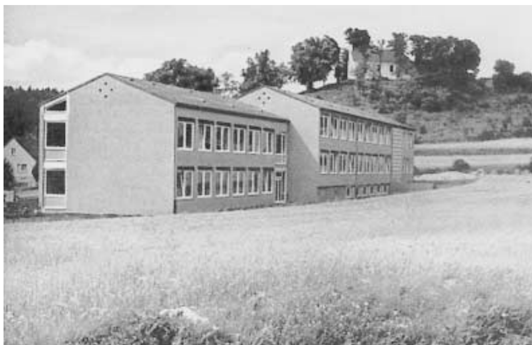
Die Johann-Baptist- Laßleben Schule in Kallmünz (erbaut 1961/62)
